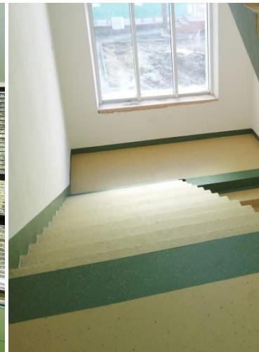
1. Бесшовные покрытия ступеней: бетонные, каучуковые, полимерные и пр.
