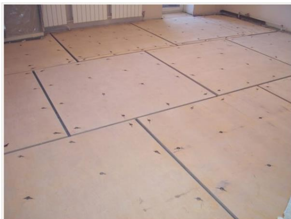
Выравнивание дощатого пола при помощи фанеры
