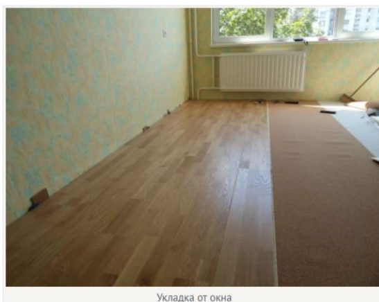
Укладка от окна
