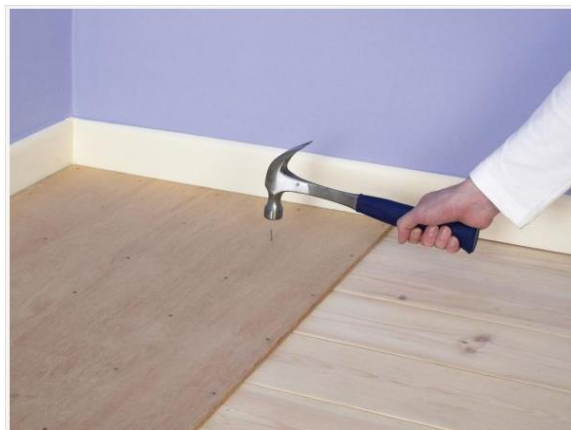
Вариант крепления фанеры к дощатому основанию
